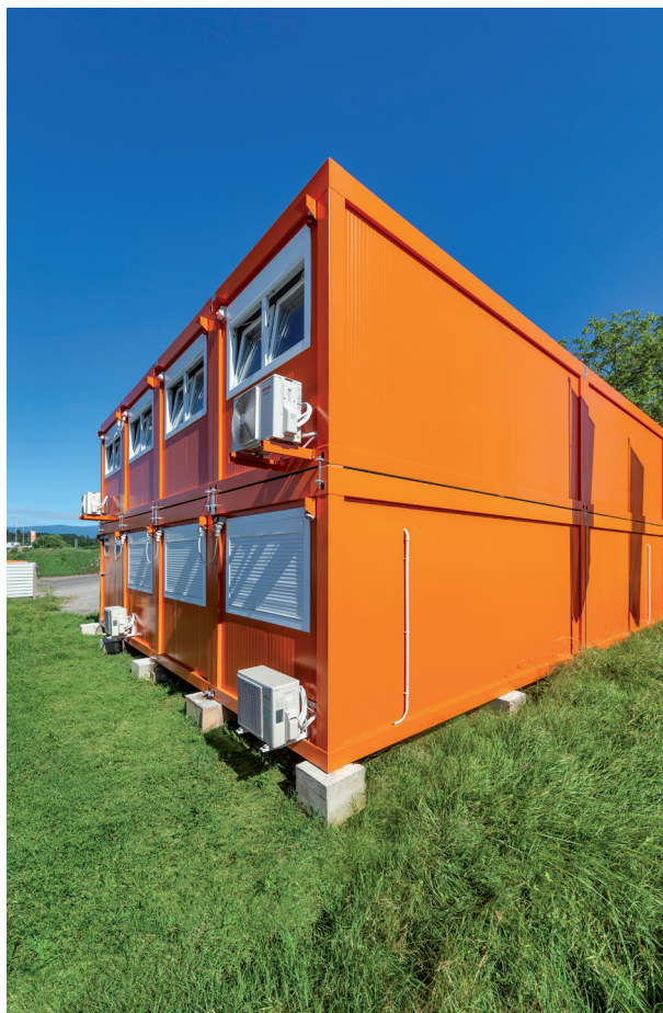
Base de vie chantier - Bussigny (VD)
